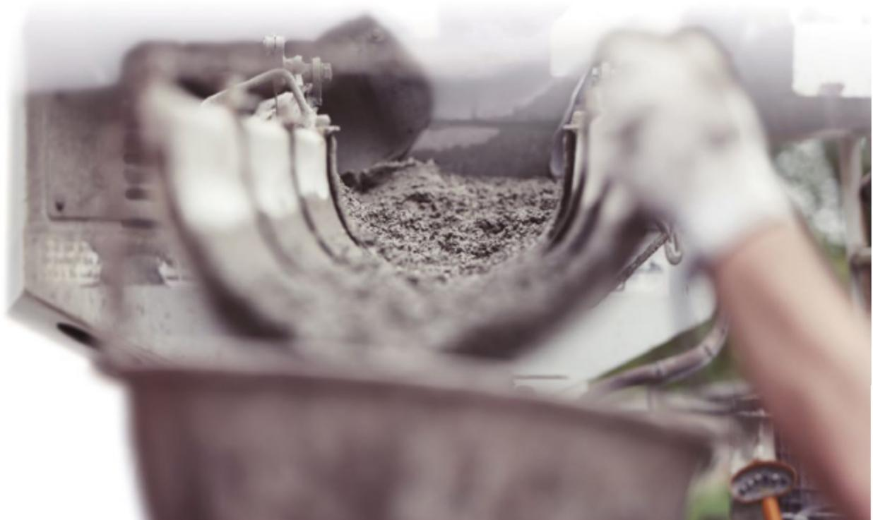
Wenn der Beton einmal abgekippt ist und abbindet, ist es zu spät. Zunächst kann man den Zementbrei vielleicht noch eine halbe Stunde hin und her schippen und ein bisschen glatt streichen, aber das war's dann. Danach ist die Sache unabänderlich in Beton gegossen ...
